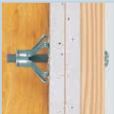
مهار جمع شونده فلزی (دیوار دو لایه)
