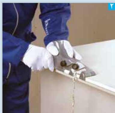
اجرای پخ با پخ زن
