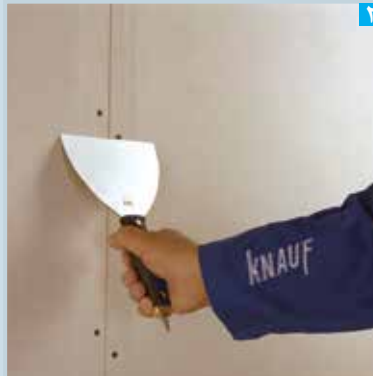
۲ بررسی بیرون زدگی پیچ ها با کاردک
