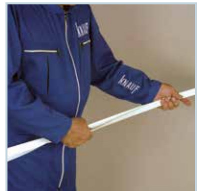
خم کردن نوار درزگیر با دست
