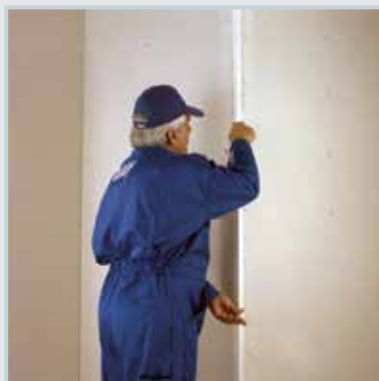
قرار دادن نوار محافظ گوشه بر روی بتونه
