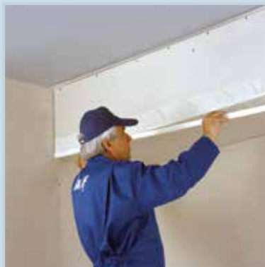
قرار دادن نوار درزگیر بر روی بتونه
