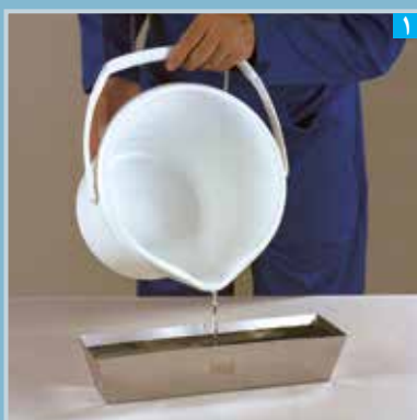
ریختن آب در ظرف تهیه بتونه
