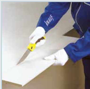
برش پنل با اره دستی
