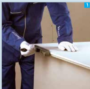
پرداخت لبه برش خورده با رنده
