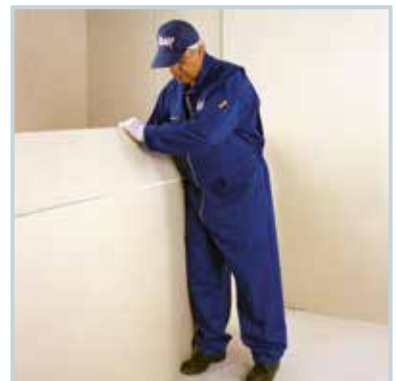
برش پنل با دستگاه برش طولی
