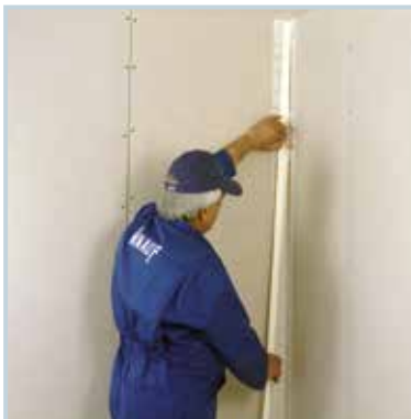
قرار دادن نوار درزگیر بر روی بتونه
