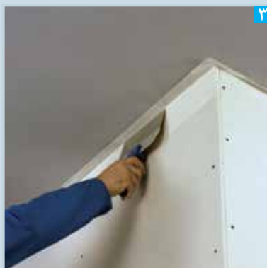
۳ بتونه کاری در فصل مشترک دیوار خشک و سقف بنایی
