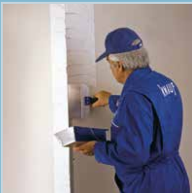
اجرای بتونه بر روی سازه محافظ گوشه
