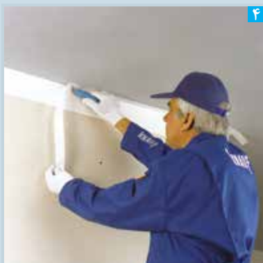
۴ برش اضافات نوار چسب جداکننده، پس از خشک شدن بتونه
