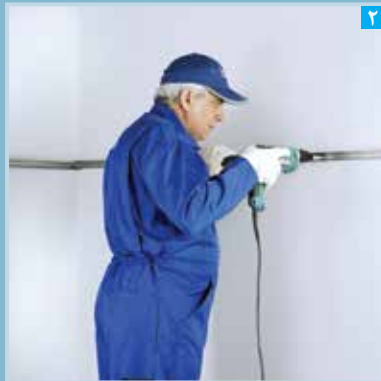
۲ نصب سازه تراز
