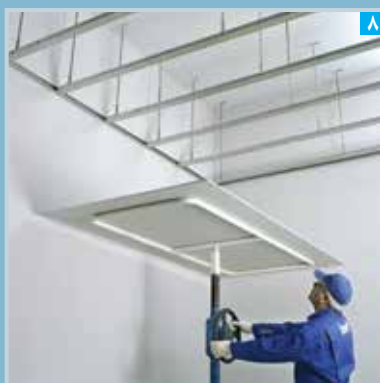
استقرار پتل با استفاده از بالابر
