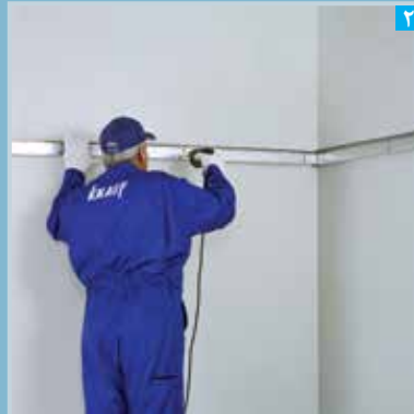
۲ نصب سازه تراز باربر
