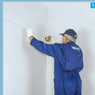
مشخص کردن محل نصب سازه تراز با ریسمان رنگی
