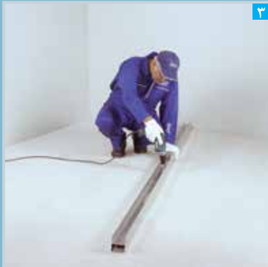
۳ اجرای سازه سقفی دوتایی
