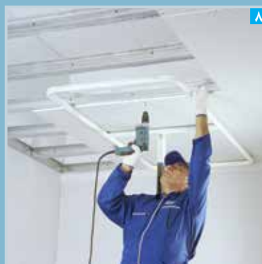
۸ اتصال پنل به زیرسازی توسط پیچ کناف
