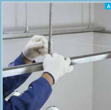
۸ اتصال رکاب به آویز و رگلاژ سقف توسط پین
