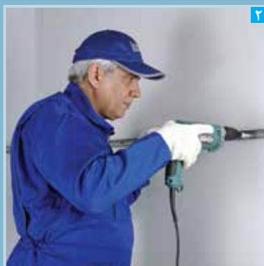
نصب سازه تراز
