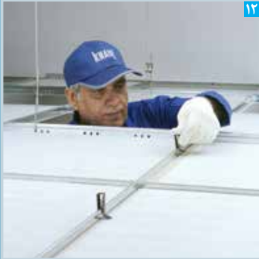
قرار دادن گیره های مخصوص نگهدارنده تایل
