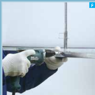
اتصال سازه باربر به چنگک توسط پیچ LN
