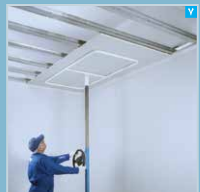
۷ استقرار پنل با استفاده از بالابر
