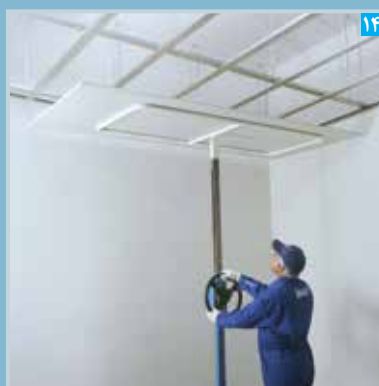
استقرار پتل با استفاده از بالابر
