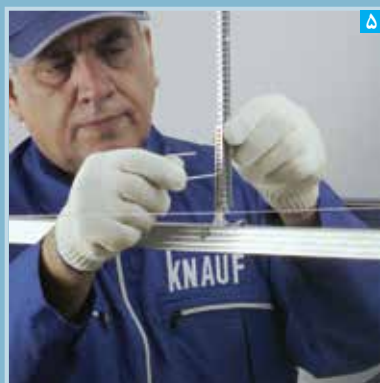
اتصال چنگک به آویز و رگلاژ سقف توسط پین
