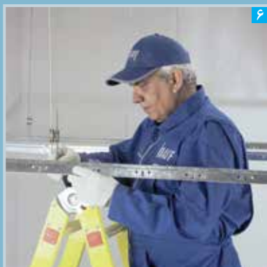
اجرای سازه های اصلی T3600
