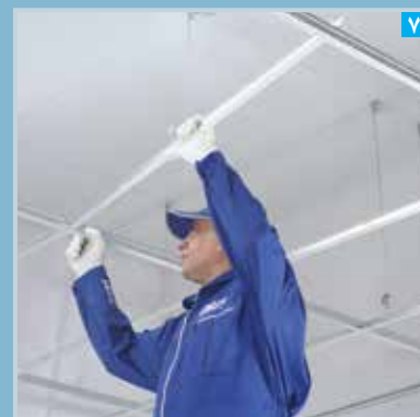
اجرای سازه های فرعی T1200
