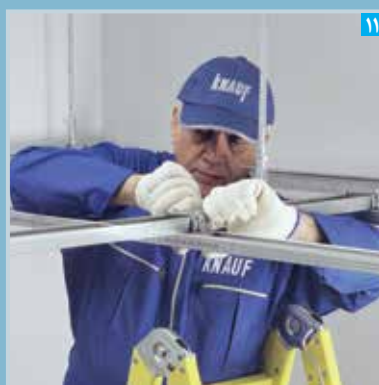
اتصال سازه پتل خور به سازه باربر توسط پل
