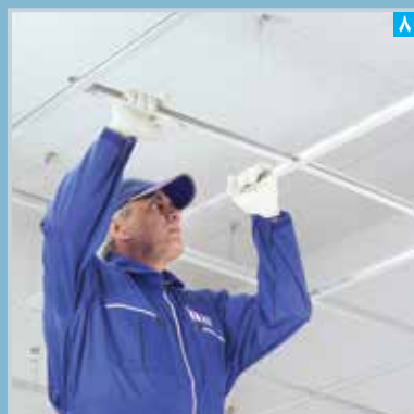
اجرای سازه های فرعی T600
